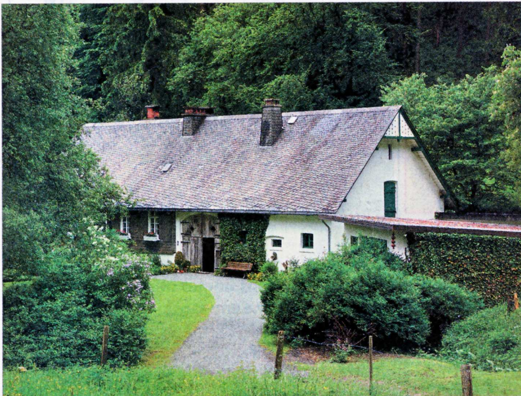
Zum Denkmal des Monats Februar kürte die Regionalgruppe das ehemalige Forsthaus Rehsiepen in Schmallenberg. Foto: AG Historische Stadtkerne
